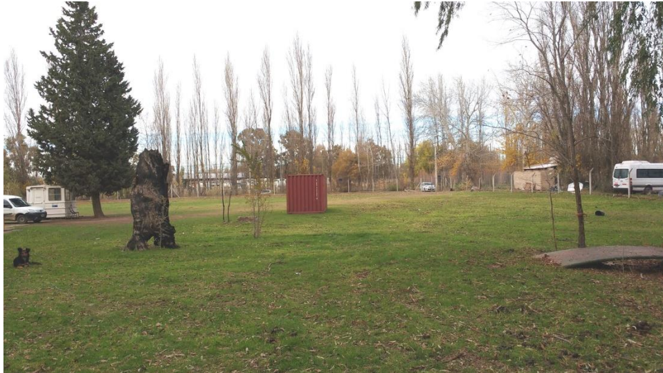
Fotografía tomada desde el perímetro de la torre, hacia el ingreso al predio. No se observó inicio de obra al 5 de junio de 2019.
